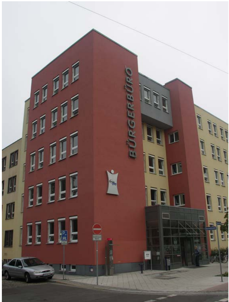
Bürgerbüro Mitte on Breiter Weg
