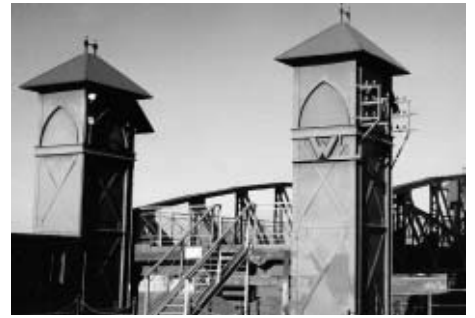
Hubbrücke im Handelshafen
