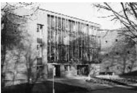
Nach nur 14-monatiger Bauzeit wurde 2000 das Institutsgebäude, Haus 44, übergeben.
