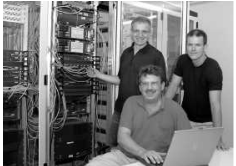
Die beteiligten Mitarbeiter des Medizinischen Rechenzentrums an einem zentralen Netzwerkverteiler (von links: Dr. Martin Kunert, Harald Leo, Tobias Mündel)
