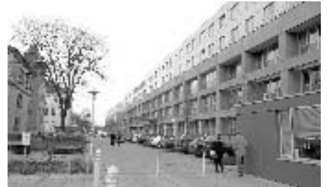
Der Klinikneubau Haus 60
